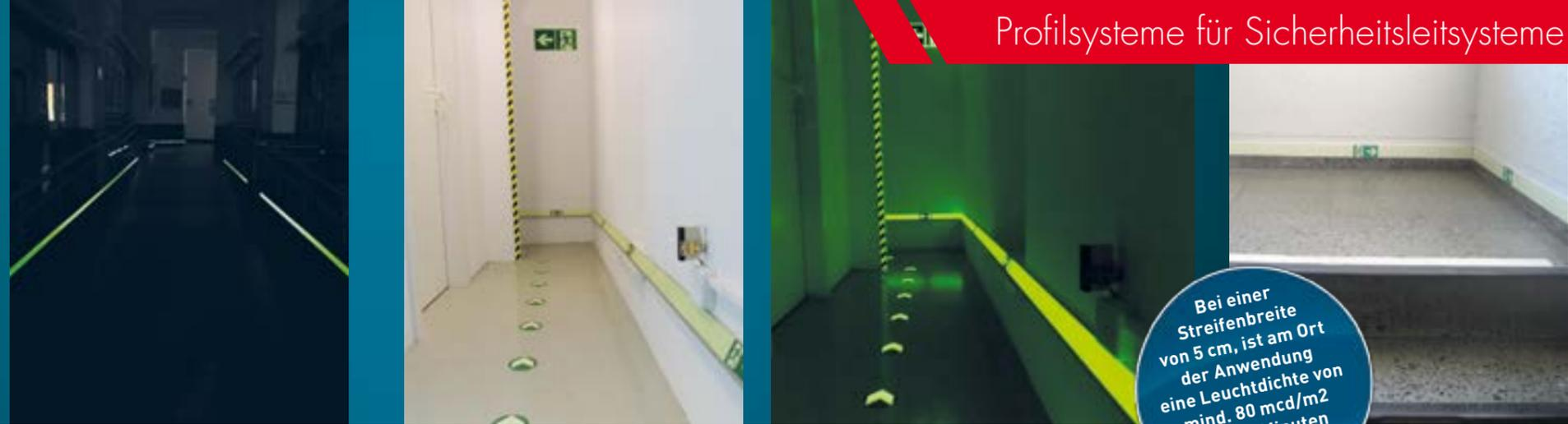
Bei einer Streifenbreite von 5 cm, ist am Ort der Anwendung eine Leuchtdichte von mind. 80 mcd/m<sup>2</sup> nach 10 Minuten erforderlich.
